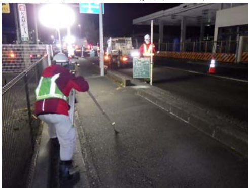
(レベルによる検測 写真)
