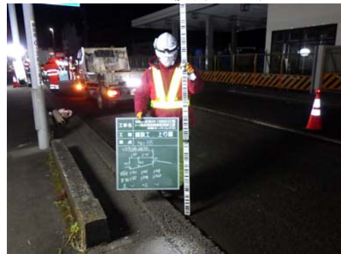
(レベルによる検測 写真)
