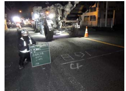
施工時(過積載防止1台目)
