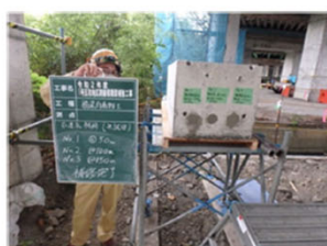
供試体でのモルタル充填完了
