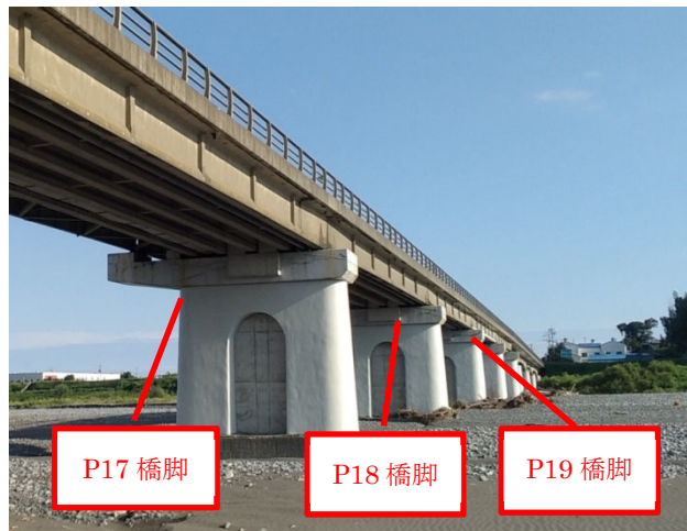
施工箇所全景 (大井川上流より)
