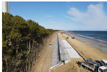
【コンクリート被覆 法面部】
