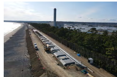
【コンクリート被覆 天端部】
