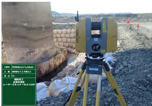
LSによる現況測量 (P2橋脚)
