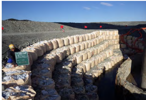
掘削法面 大型土のう設置
