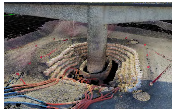
点群データ取得 (P2橋脚)
