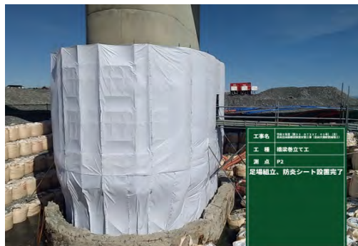
防災シートの設置
