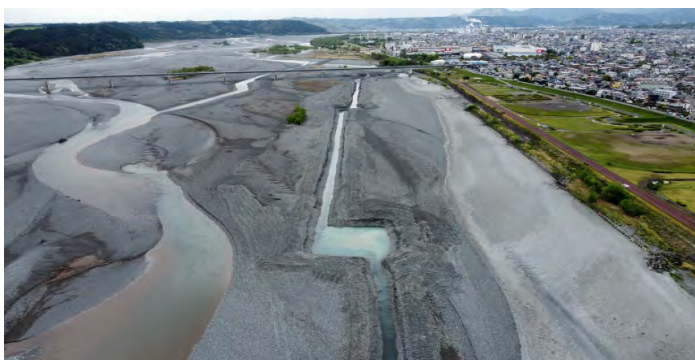
仮排水路設置 (L=800m)
