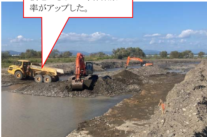
重ダンプ(25t)土砂積込
