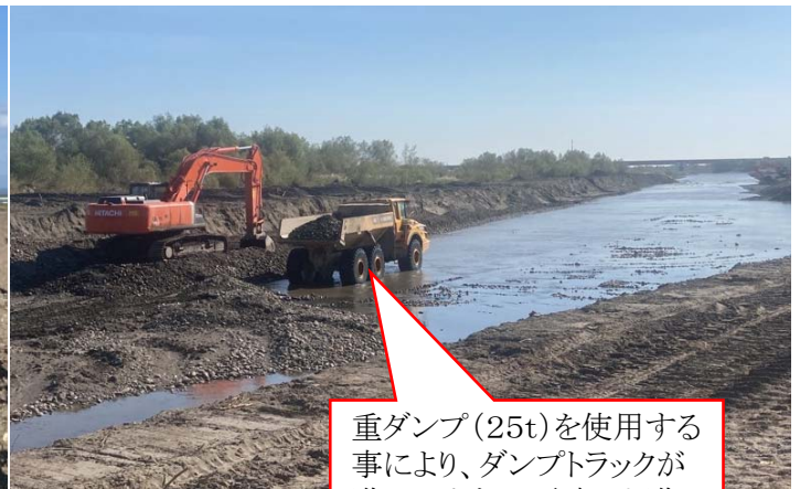
重ダンプ(25t)土砂積込
