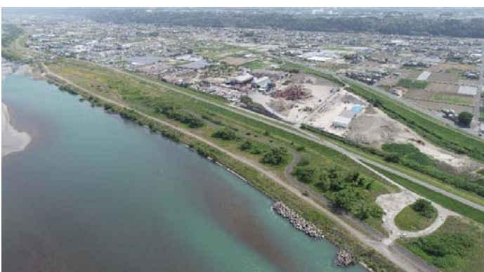
写真：着手前(下流から上流を望む)
