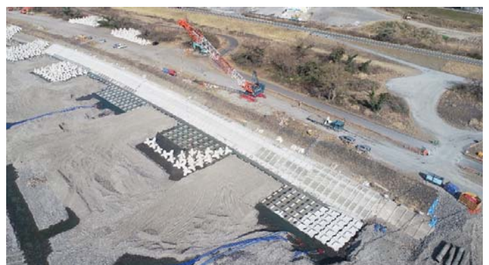
写真：完成(下流から上流を望む)
