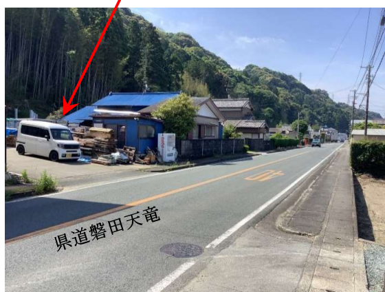
施工箇所 (起点付近)
