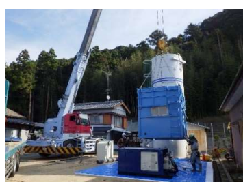
プラント設置状況
