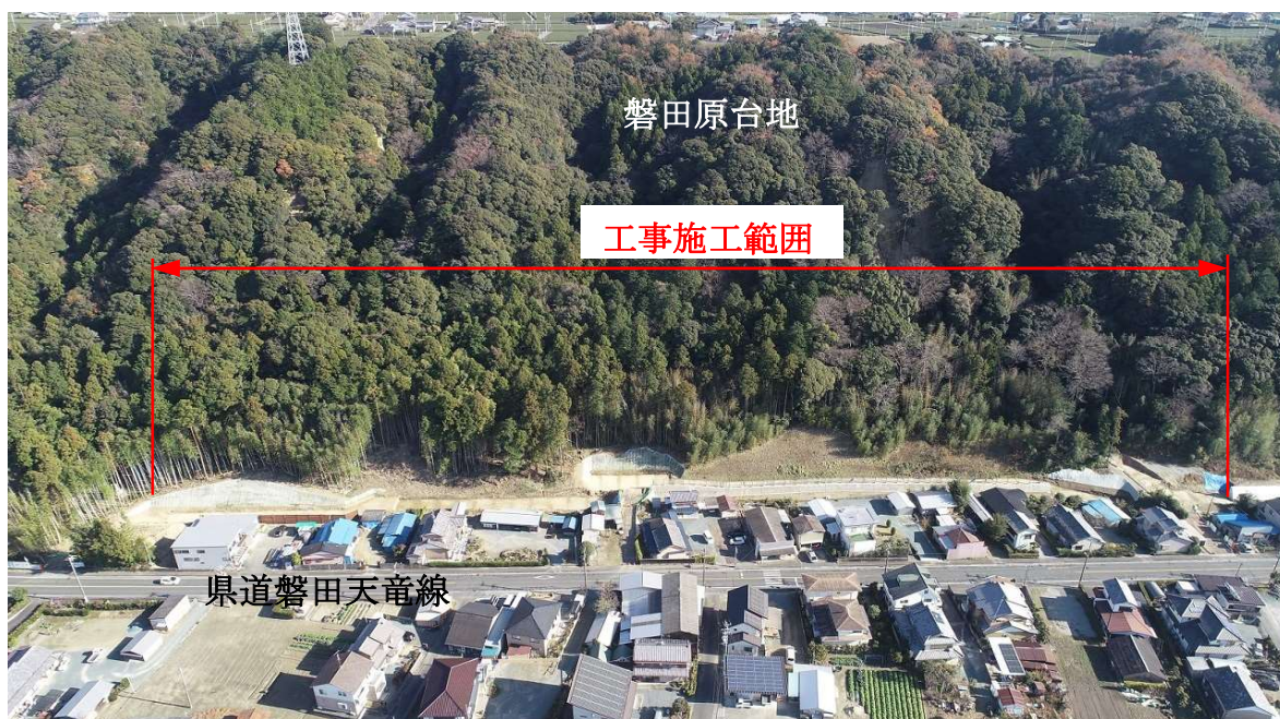
完成時の写真(全景)
