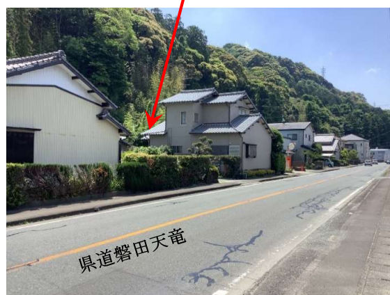
施工箇所 (終点付近)
