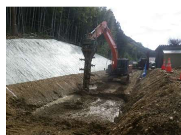
地盤改良施工状況
