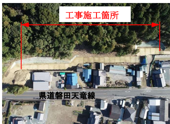
完成時の写真(起点側施工箇所)
