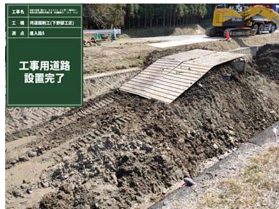
敷鉄板設置完了
