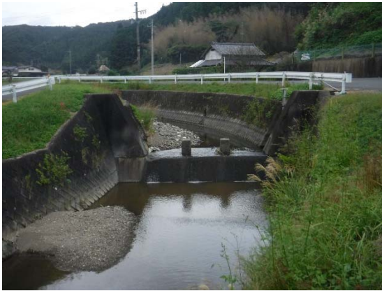
落差工 (No. 4 付近)
