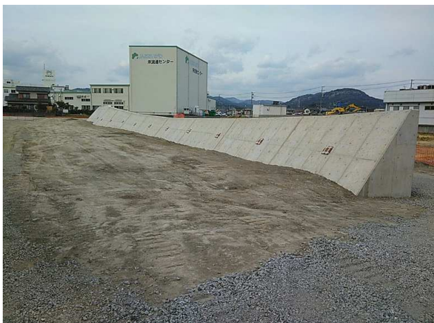
【重力式擁壁工完成写真】
