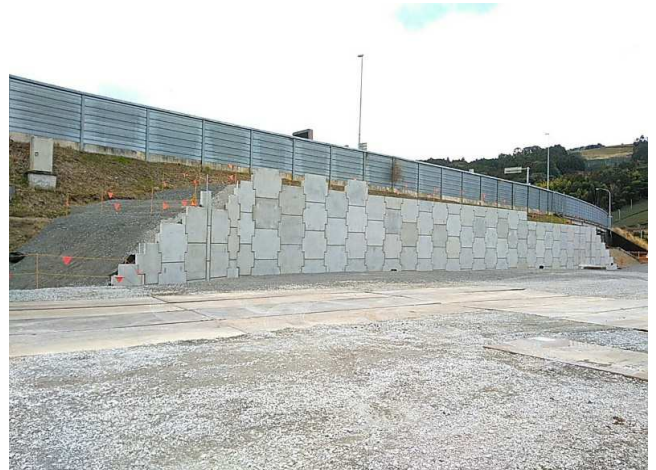
【補強土壁工完成写真】
