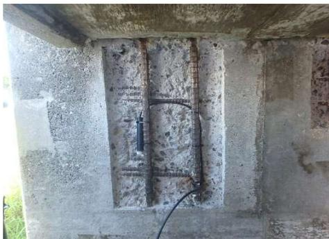
写真-7 照合電極及び排流・測定端子
