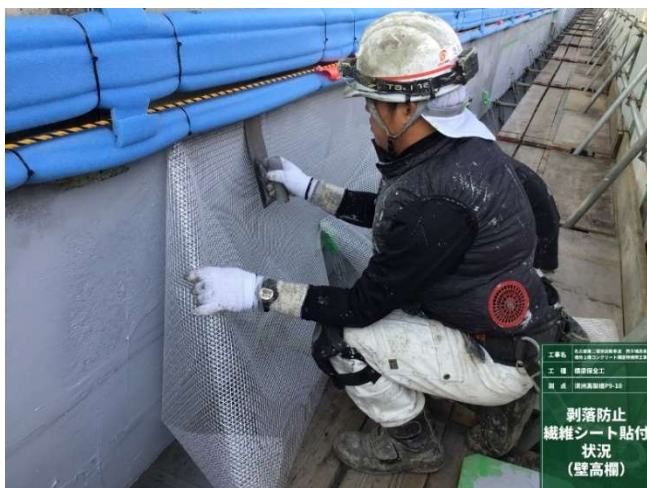
写真-1 清洲高架橋 施工状況
