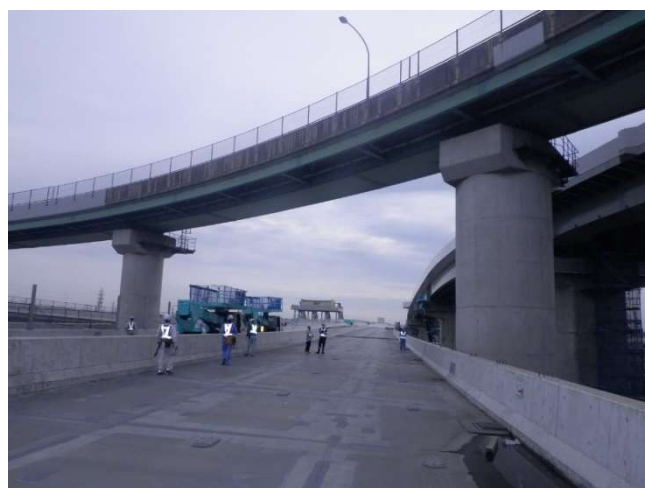
写真-2 名古屋西 JCT 着手前
