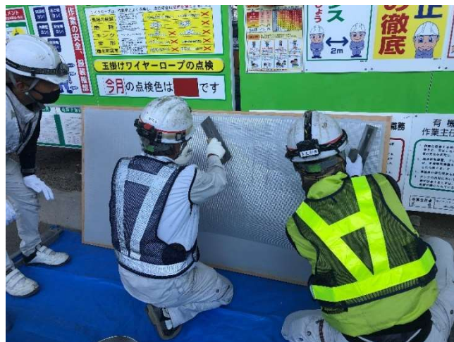
写真-3 試験施工状況
