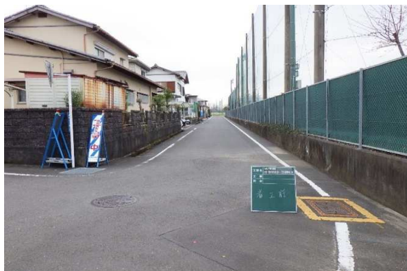
写真1：着手前(工事起点側)
