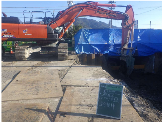
中層混合処理工
