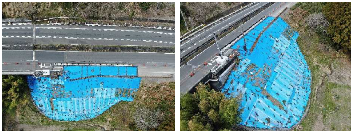
写真-4 志戸呂地区 完成写真
