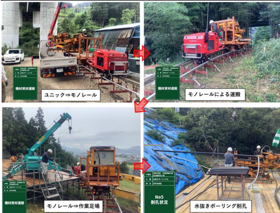
図-3 志戸呂施工方法の検討（水抜きボーリング）
