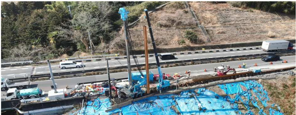
写真-3 ノンステーキング工法+硬質地盤クリア工法 併用施工状況
