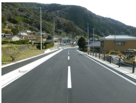
(施工完成起点)
