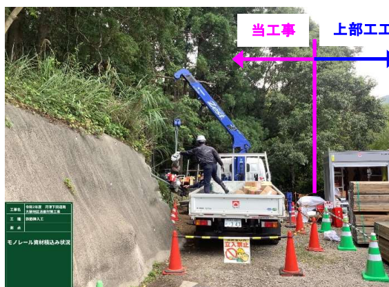
資機材小運搬（モノレール荷揚げ・荷卸しヤード）
