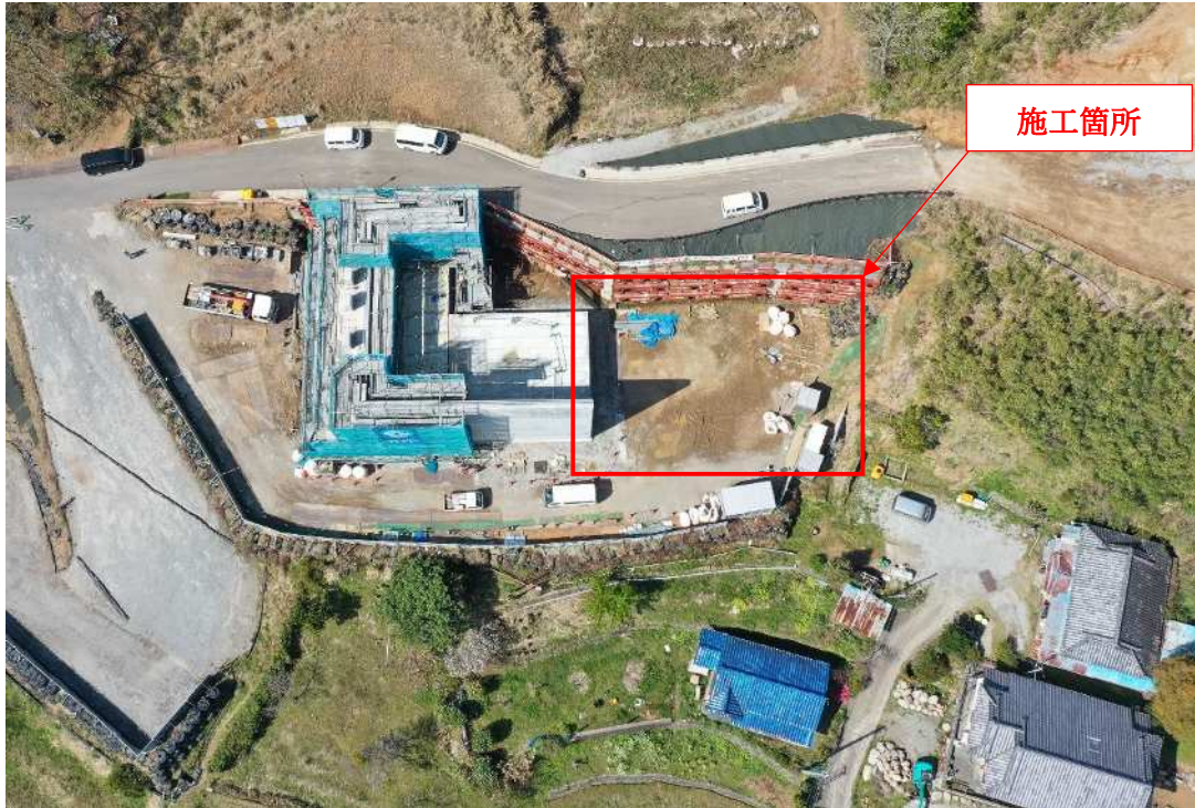
本工事着手前状況
