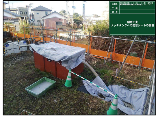
写真-4 排水箇所への防音シート設置
