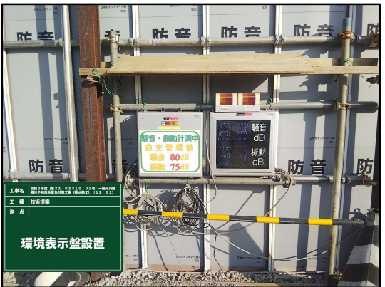
写真-6 環境表示板設置状況(騒音・振動)
