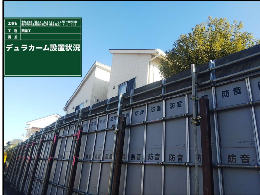
写真-3 防音パネルの嵩上げ
