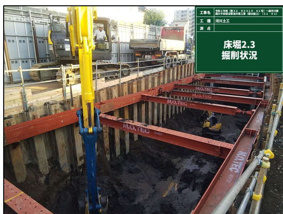
写真-7 後方小旋回 0.7m3BH(ロングアーム)
