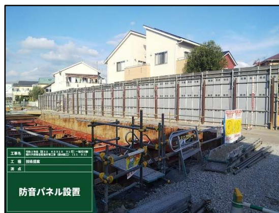
写真-2 防音パネル設置
