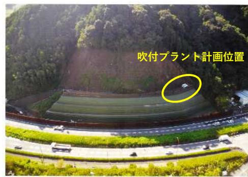
伐採完了後撮影
