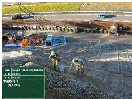
下地吹付状況
