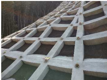
箱抜き穴設置
