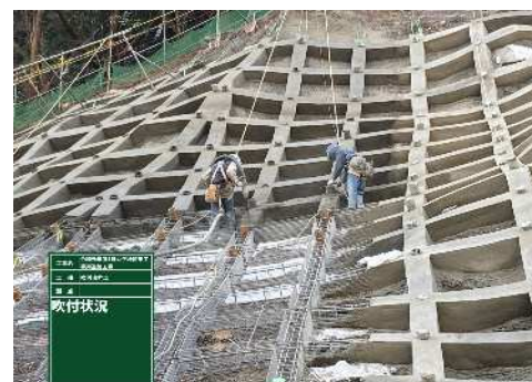
吹付作業状況
