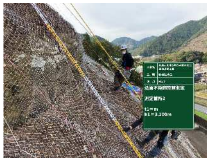
不陸調整箇所測定
