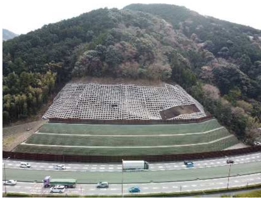
法枠吹付工完了
