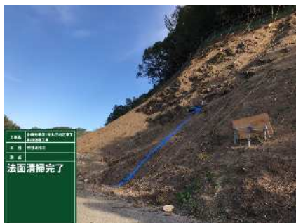
法面清掃後の現況
