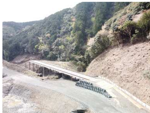
仮栈橋工事 着手
