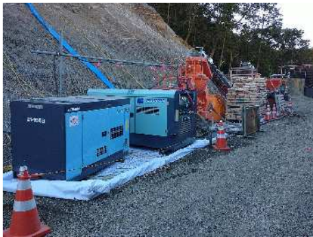
吹付プラント設置状況
