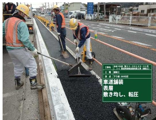
狭い中での施工
