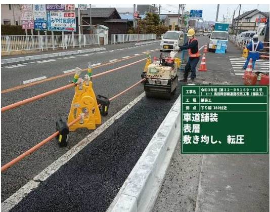
狭い中での施工
