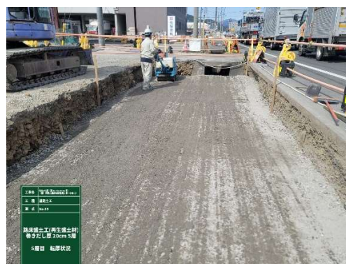
【路床盛土作業】
