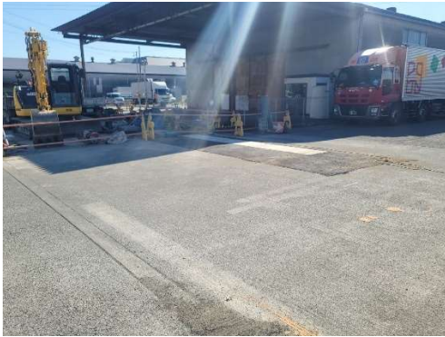
【側溝工分割施工】
