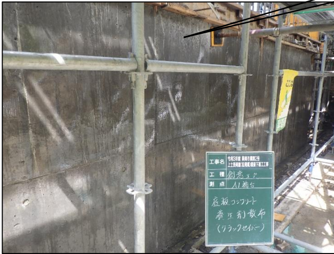
写真-5 被膜養生状況
