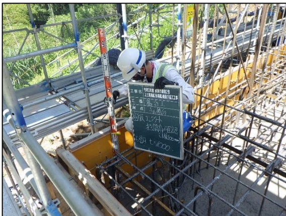
写真-2 打設高確認状況
