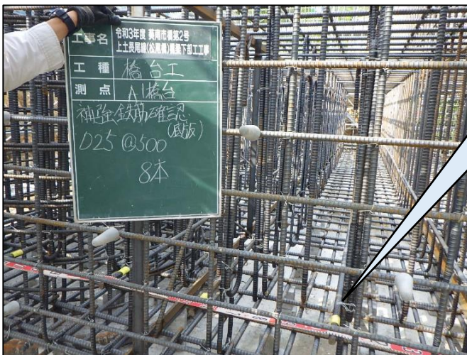
写真-1 底板部 補強鉄筋配筋
