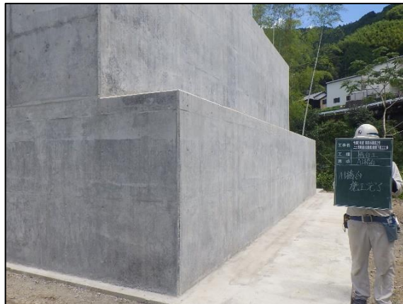
写真-3 コンクリート打設完了
