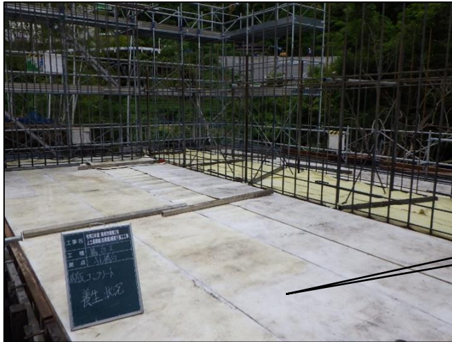
写真-4 養生状況
