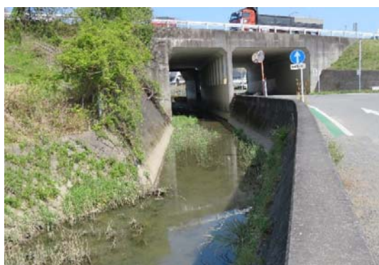
施工前(河川側)
