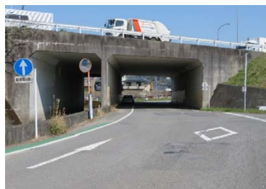
施工前(道路側)
