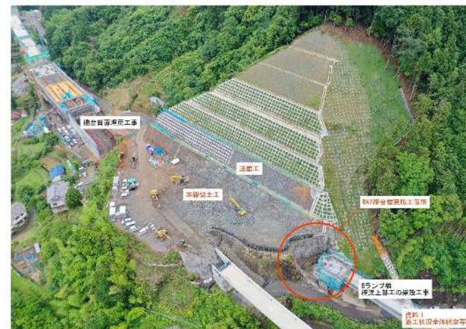
資料1：施工状況全体航空写真
