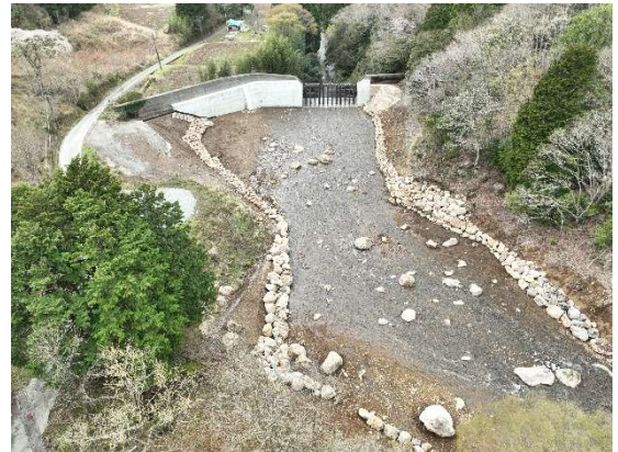
写真-2 ICT 施工完了
