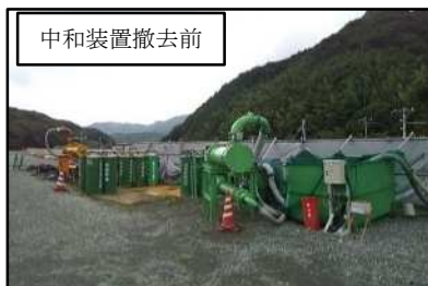
【1次施工】中和装置設置
