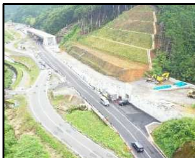
【国道414号切り回し後】
