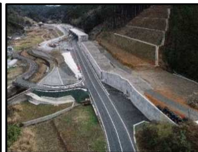
【補強土壁完了時】
