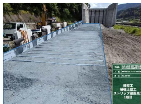
左側補強土壁施工状況
