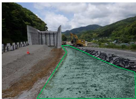
影響部の先行施工
