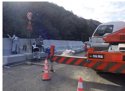
剛性防護柵基礎据付状況
