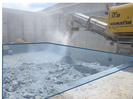
改良土盛土状況
