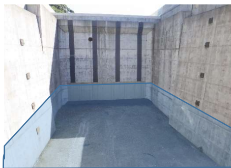
3号橋橋台背面部盛土箇所
