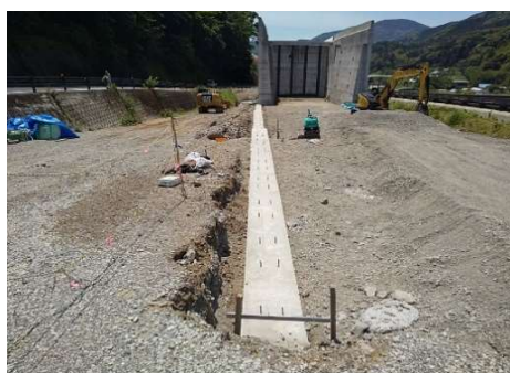
補強土壁基礎工
