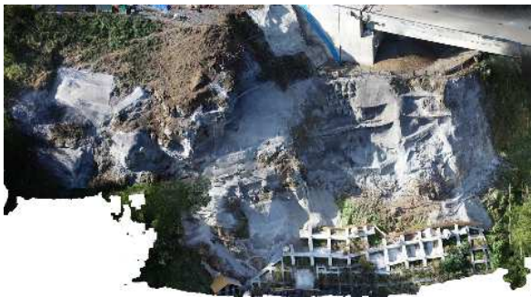
【不陸調整ソイルセメント吹付完了後】
