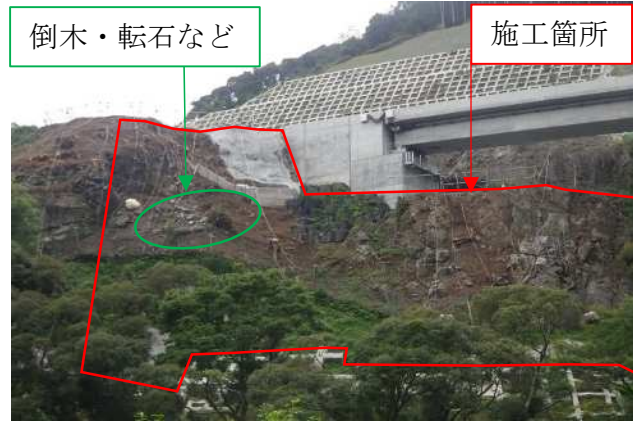
【 伐採・法面清掃完了後 】
