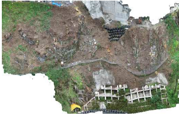
【ソイルセメント吹付完了後】
