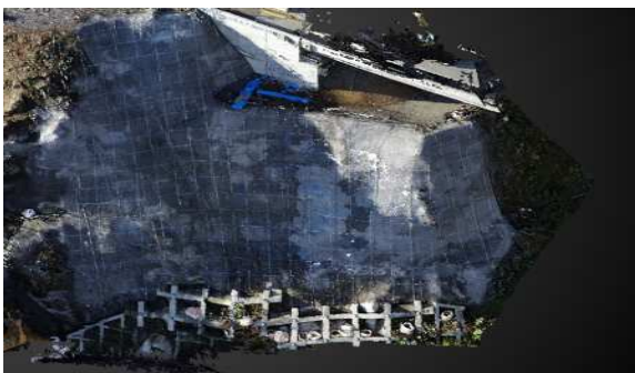
【不陸調整ソイルセメント吹付完了後】
