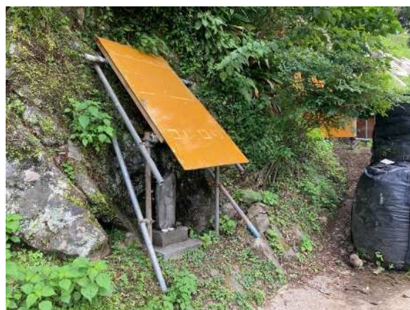
【 地蔵菩薩への防護対策：防護屋根の設置 】
