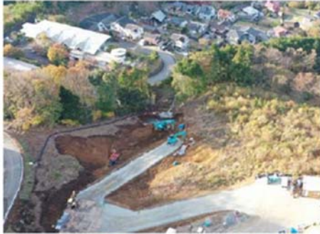
奥の沢第3砂防堰堤側壁・水叩き(2)
