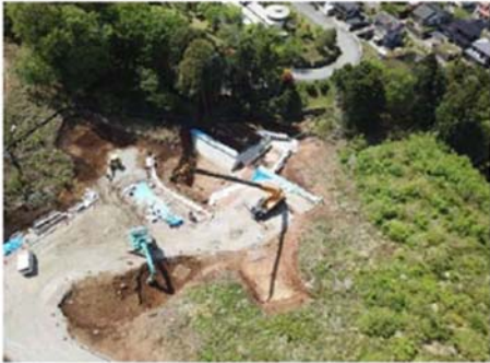
奥の沢第3砂防堰堤側壁・水叩き(1)
