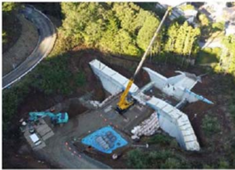
奥の沢第3砂防堰堤側壁・水叩き(1)
