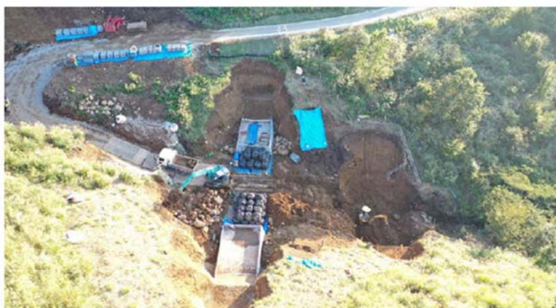
奥の沢第2砂防堰堤垂直壁掘削状況
