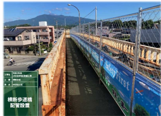
(歩道橋配管完了)
