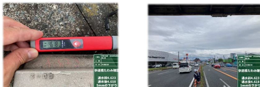
(配管積載前後の歩道橋たわみ量確認)
