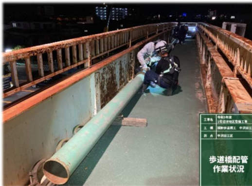
(歩道橋配管の施工状況)
