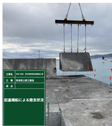
撤去専用吊り天秤使用状況
