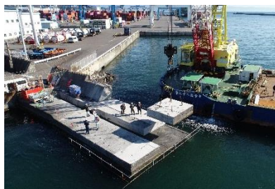
② 構造物撤去状況
