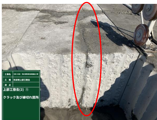
コンクリートの劣化状況(クラック、ひび割れ)
