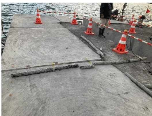
コンクリート施工継目部分(コア削孔完了後)
