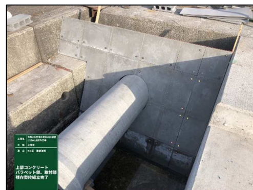
残存型枠組立状況
