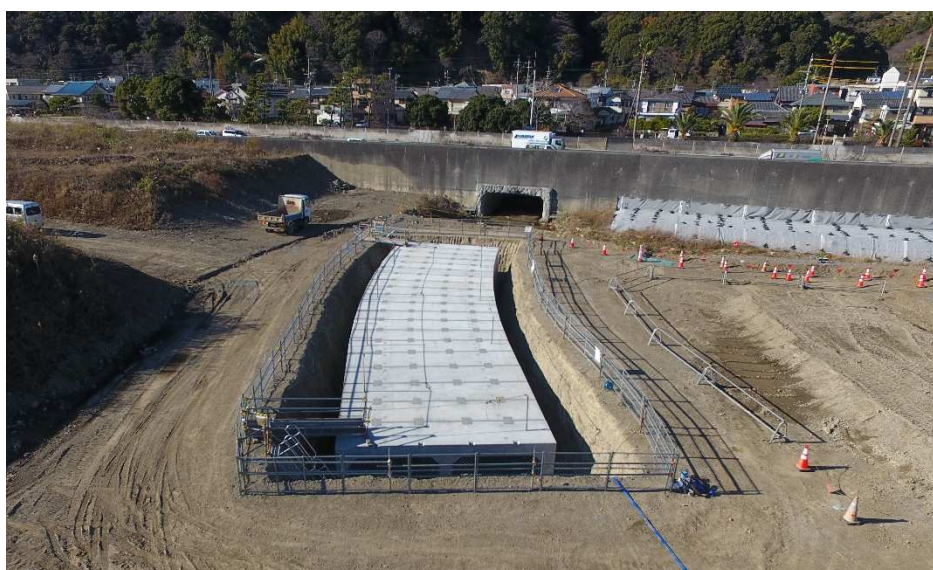
ボックスカルバート据付完了
