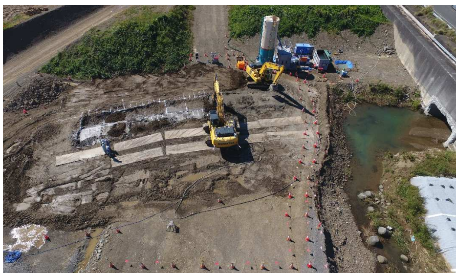
地盤改良工 WILL 工法施工状況
