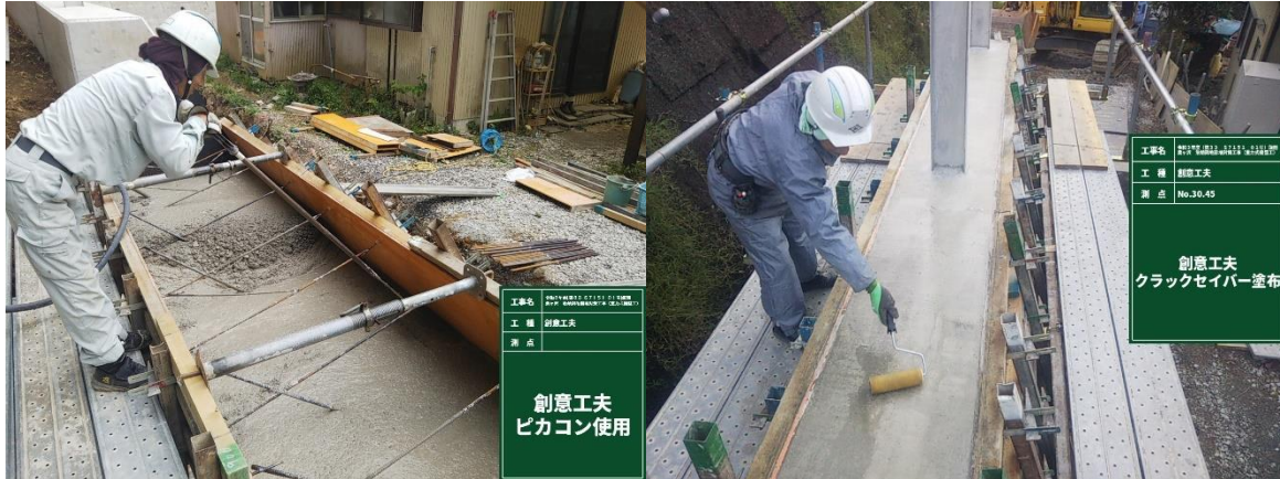
スペーシング状況(ピカコン使用)
