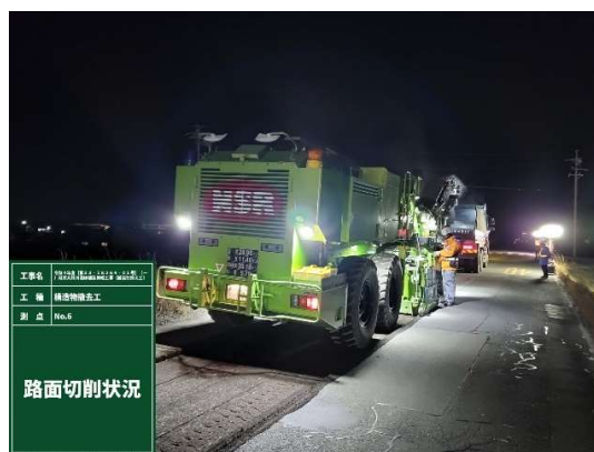
路面切削状況
