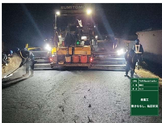
舗設状況（アスファルトフィニッシャー）
