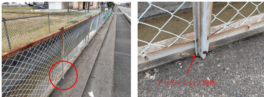
既設支柱 撤去前
