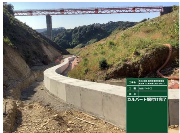
カルバート据付け完了(起点から終点)
