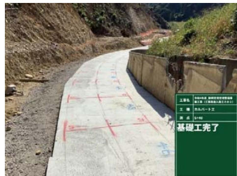
均しコン施工状況(数字はモルタル敷き厚)
