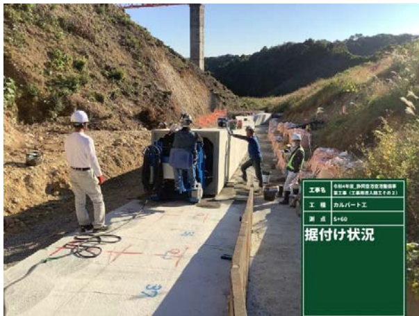
カルバート据付け状況(中間点から終点)
