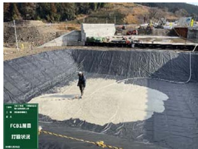
FCB打設状況
