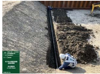
暗渠排水管布設
