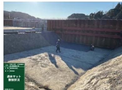
透水シート敷設
