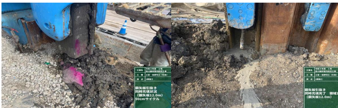
充填材オーバーフロー確認写真
