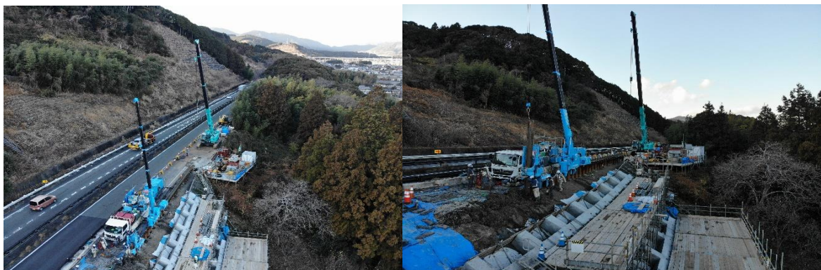
施工状況写真
