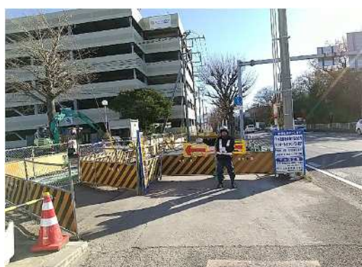
写真-1 仮囲いフェンス
