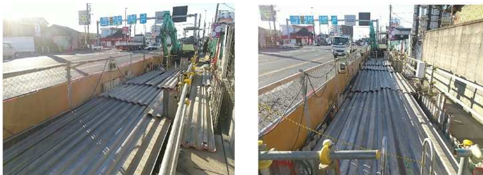
写真-6、7 アルミ鋼矢板設置状況
