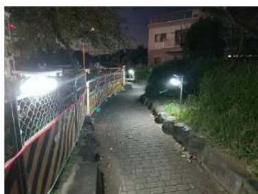
写真-4 センサー式LEDライト・チューブライト
