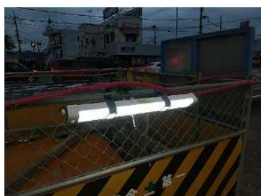
写真-3 センサー式LEDライト
