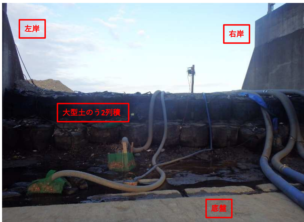
下流仮締切状況
