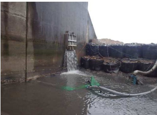
降雨河川増水状況
