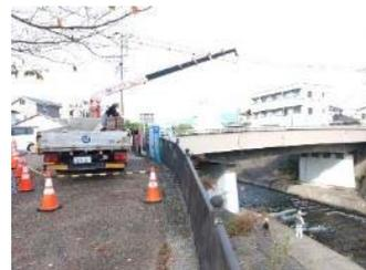
また、道路の上空に架空線があり、機械の使用時に切断をする恐れがあったため、防護管の取付けとのぼり旗による注意喚起を行うことにより、架空線切断事故防止を防ぐことができた。
