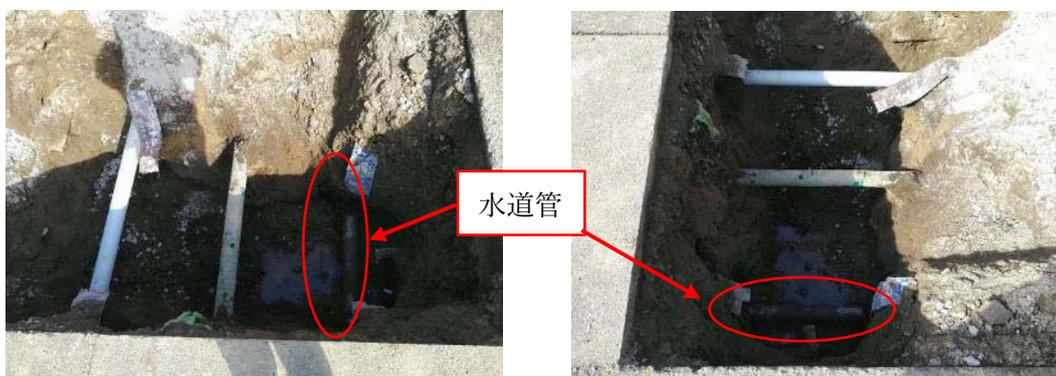
渉してしまうことが判明し、下水道本管を布設するために、施工方法や水道管の切り回しを検討する必要があった。
