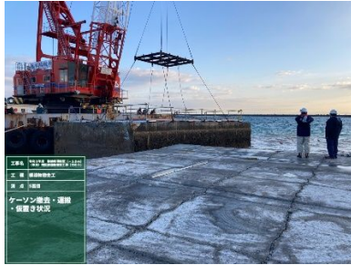
【ケーソン撤去状況】
