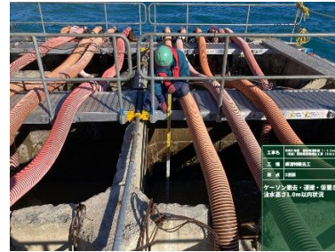
【ケーソン内水位の確認】
