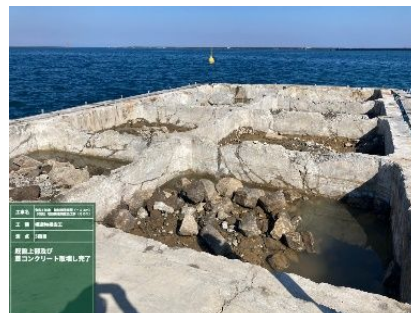
【既設ケーソンの現状】
