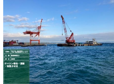
【ケーソン運搬状況】
