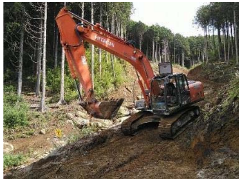
改良後重機走路
