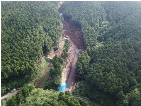
仮設進入路完成
