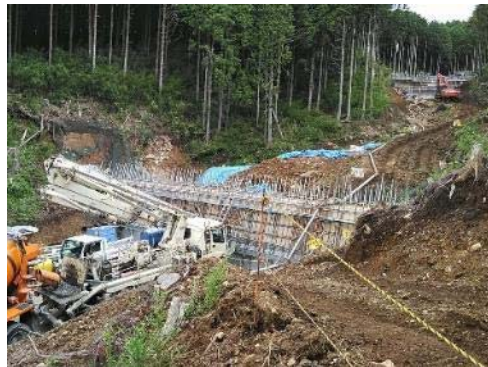
コンクリート圧送配管
