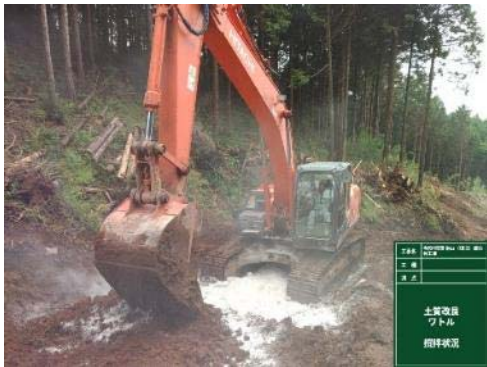
土質改良状況
