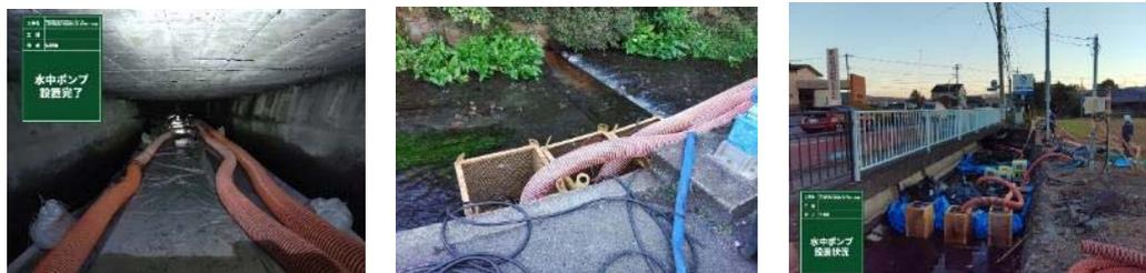
土のうを使用し、堰を作成した。平田橋において万が一、大雨が降った際、越流をさせ、道路や横の土地に水が溢れないように計画をした。また、平田橋の現状の流量では水中ポンプによる水替えが困難となるため、用水路の上流にある中郷温水池公園において堰を作成（コンパネ、バタ角、ジャッキ）し、用水路内の減水を行った。結果的に流量を小さくすることができ、水中ポンプによる水替えが可能となり、施工を円滑に進めることができた。
