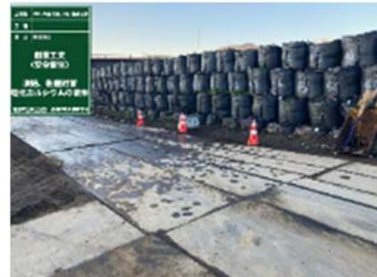
土工面が露出される箇所にはダストストッパーを散布し対応した。ダストストッパーは接触する固形物(砂塵粒子)と結合しフィルムバリアを形成する。フィルムバリアは不要性のため雨水に溶けず効果が持続する。
