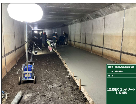
写真-5 底張りコンクリート施工状況
