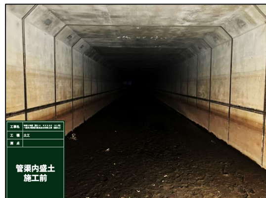
写真-2 函渠内施工前
