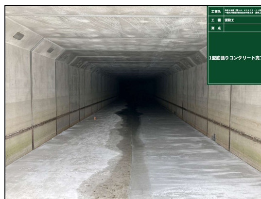
写真-6 底張りコンクリート完了
