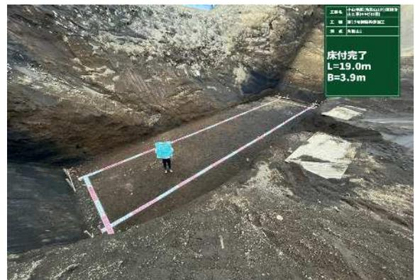
写真-7 鋼製枠床固工 床付完了
